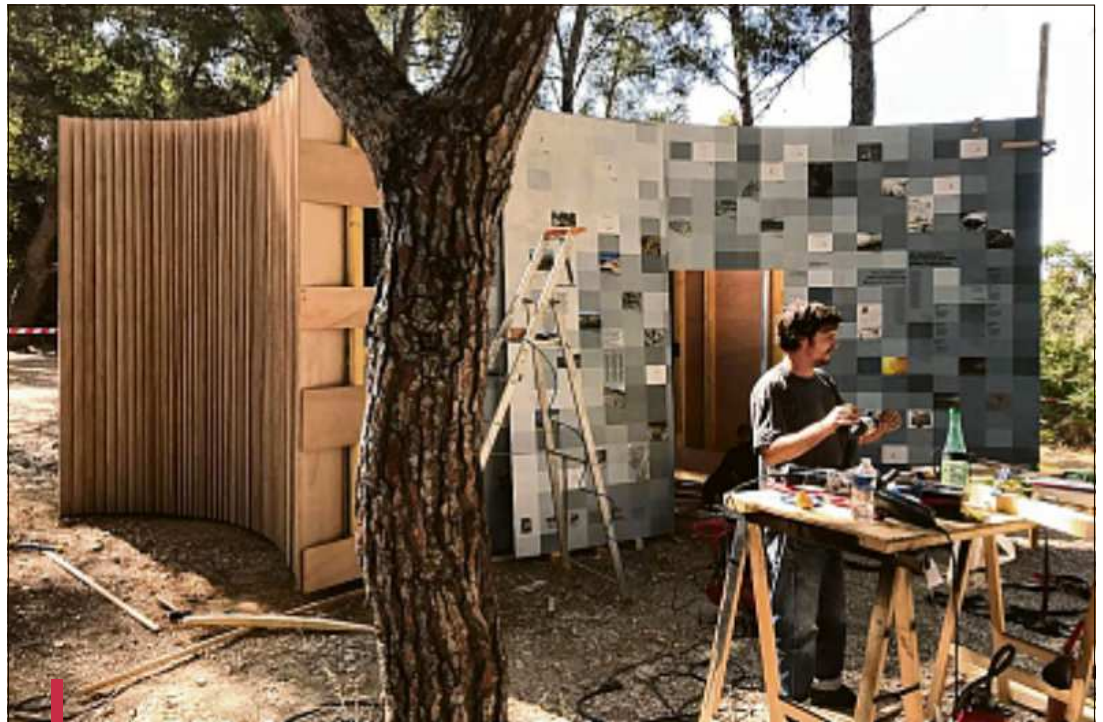
Les créations de Ryo Abe en cours d'installation sur le site de l'ancienne carrière Solvay à Port Miou.
